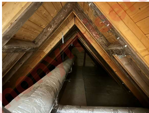
På sidebygningerne er der udført fast undertag, som fremstår korrekt udført og formodes etableret i 2008.
