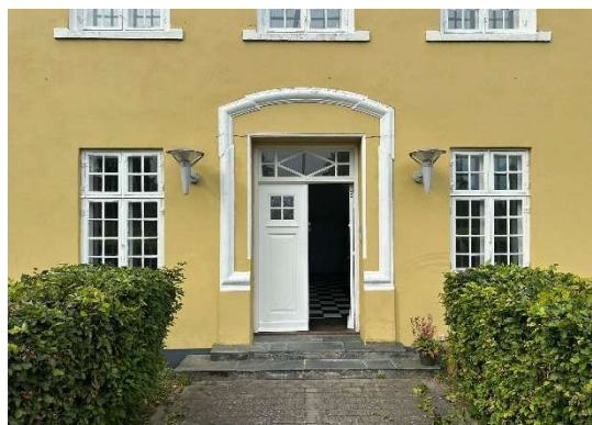
Hoveddøren til trappeopgangen mod syd er sandsynligvis oprindelig. En fin, ældre hoveddør.
