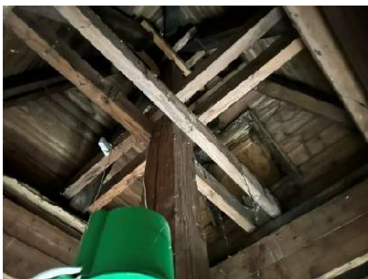
Billede fra tårnet med urværket, indefra. Det tilgængelige træværk fremstod i acceptabel stand og uden tegn på fugt
